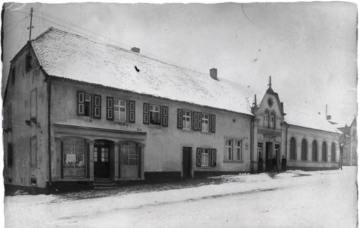
„Lauer'sch Wertschaft“, rechte Gebäudehälfte, gen. Bett'sches Saal, war seit 1850 der Wellesweiler Veranstaltungsort für Feierlichkeiten jeglicher Art. (ehem. Standort Ecke Homburger Straße – Hirtenstraße)
