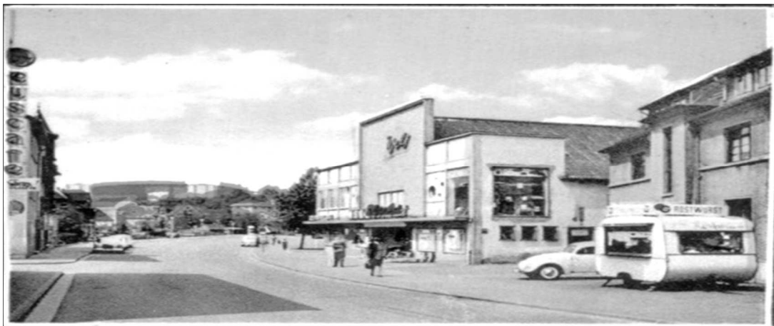
Einst beherrschend im Ortsbild: das Gebäude des einstigen Kinos „Weli“ und das Haus der Fam. Eli
