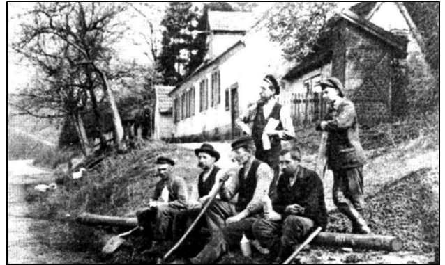
Ein Arbeitertrupp beim Setzen der Lichtmaste in der Rombach
