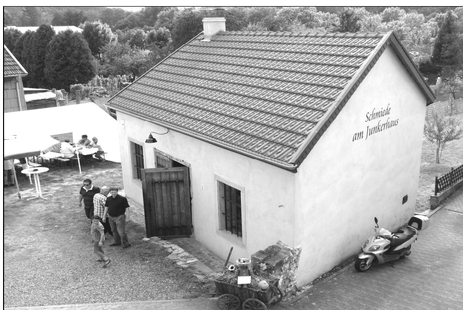
Ein altes Stück Wellesweiler – Junkerhaus und Schmiede in der Eisenbahnstrasse 22 -24
